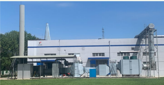
通用技术中纺院新增 55000m 3 /h 废气处理设施项目，处理车间内烘干、涂布产生的有机废气
